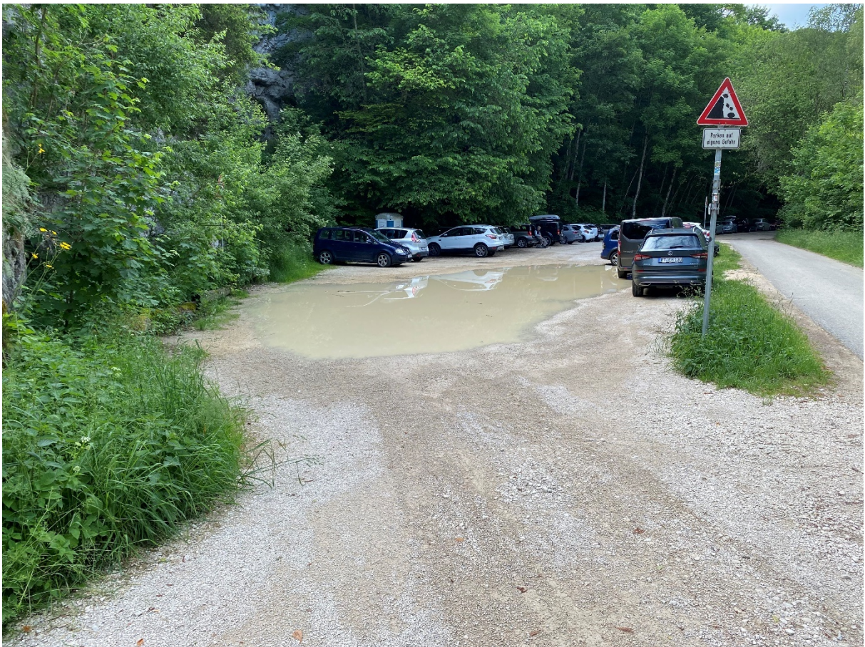
Abbildung 83: Parkplatz Anhausen nach Regenfällen
